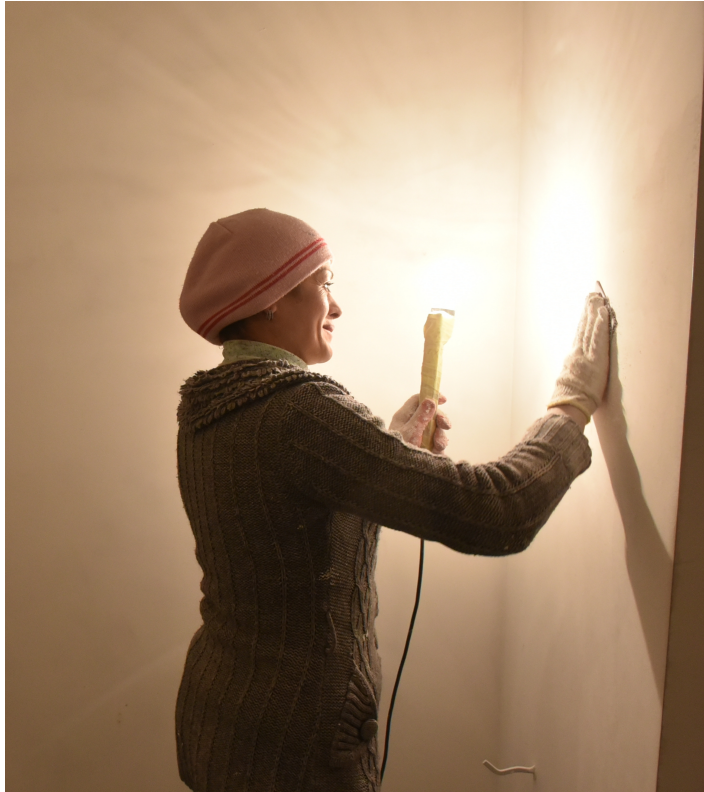
Hier wird gerade der Putz kontrolliert. Frauen auf dem Bau sind in Moldawien keine Seltenheit.
